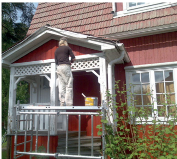
† Maalityyppeä ei vaihdettu vaan seinät maalattiin vesiohenteisella maalilla, jolla ne oli edelliskerrallakin käsitelty.
